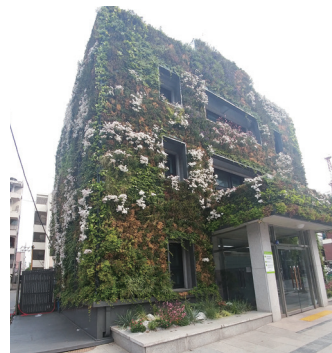
시공 3개월 후(11월)
