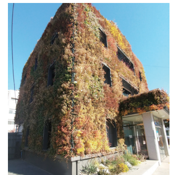
시공 4개월 후(12월)
