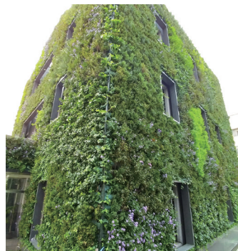
시공 후 (8월)
